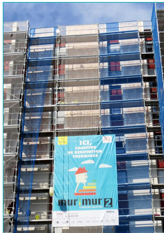
Bâtiment en cours de rénovation avec le projet Mur | Mur (© Grenoble-Alpes Métropole)
